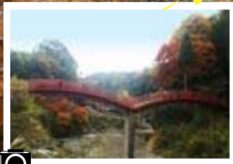
観音橋は養老溪谷のシンボル
